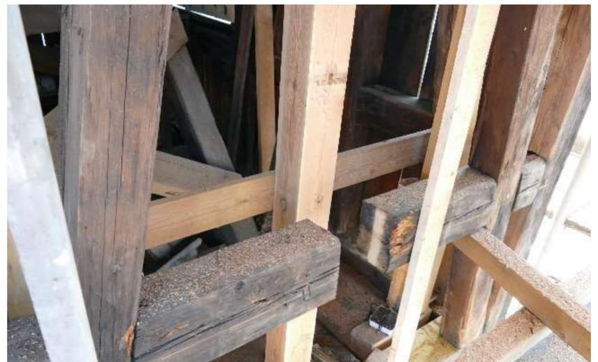
**Turmgebälk** Die Konstruktion wird durch neue Balken verstärkt
