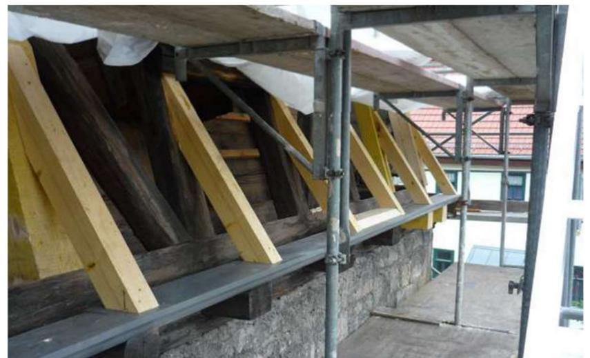
**Dachgebälk** Beschädigte Dachbalken wurden durch neue ersetzt
