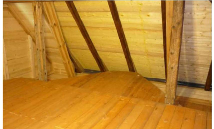
**Innenverkleidung Kirchenschiffdach** Neue Verkleidung des Kirchenschiffdaches
