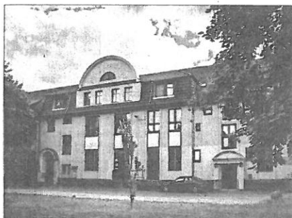
Alte Hülle, junge Seele: Das 1925 erbaute Gebäude der Harfe Druckerei in Bad Blankenburg beherbergt heute das Begegnungs- und Schulungszentrum von »Jugend mit einer Mission«.
